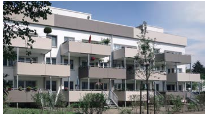
Abb. 1: Aufstockung des ersten Projektes, Südansicht
