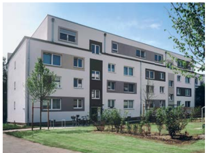
Abb. 2: Nordansicht des fertiggestellten ersten Projektes: Die drei unteren Bestandsgeschosse wurden saniert, das obere Staffelgeschoss in Holzbauweise aufgesetzt.
