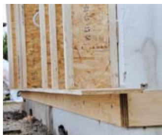
Abb. 5: Bilder vom Bauen mit Stegträgern: a) Sockelpunkt b) Dachsparren und Anschlussstreifen zu Luftdichtung c) Leibungskasten mit Luftdichtung an Außenputz d) Einblasen von Zellulosedämmung
