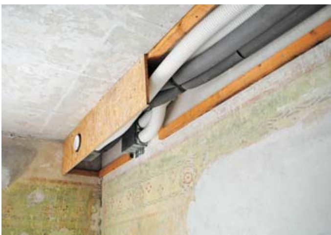
Abb. 9: Lüftungsinstallation a) Abköfferung zur Aufnahme von Lüftungs- und Heizleitungen b) Luftverteilerkästen Abluft und Zu- und Luft mit flexiblen Anschlussleitungen c) Wärmerückgewinnungsgerät „Novus“ der Firma Paul
